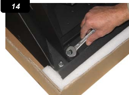
14. Schrauben Sie nun den Mittelteil am Fußteil fest. (4 Schrauben)
